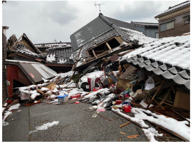
図 7 (倒壊した家屋)
